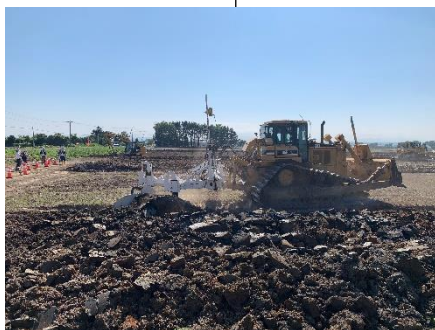
プラウ現場 見学
